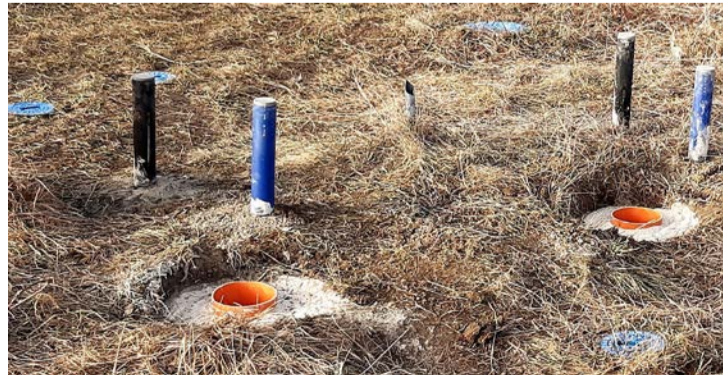
DP instalované vrtů s pojezdovým zhlavím a s pažnicí vyvedenou nad terén
