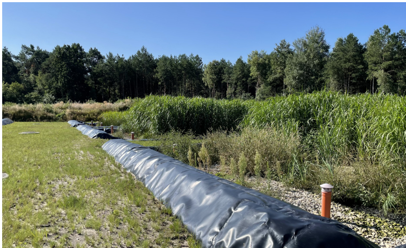
Kořenová čistírna odpadních vod v polské Bialce (rok po zprovoznění)
