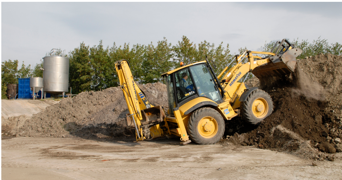
Provzdušňování zeminy na dekontaminační ploše
