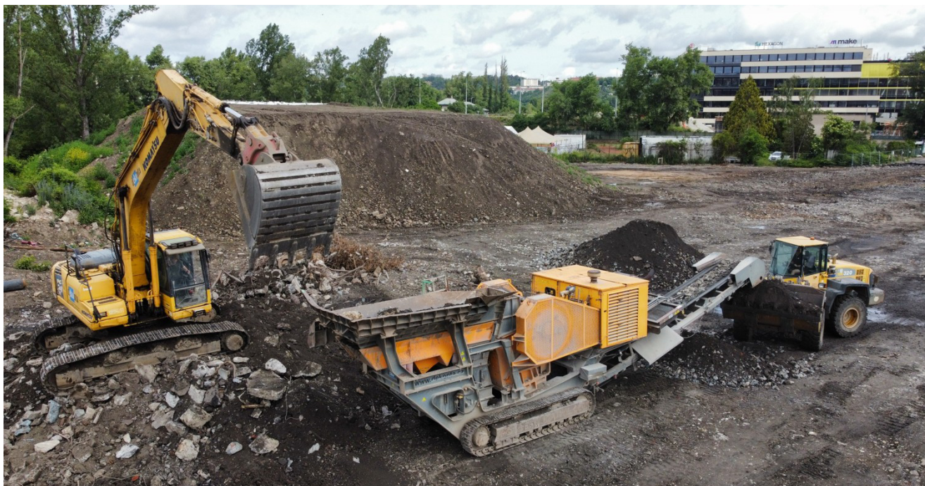
Zpracování stavebního odpadu na mobilní drtičce odpadů
