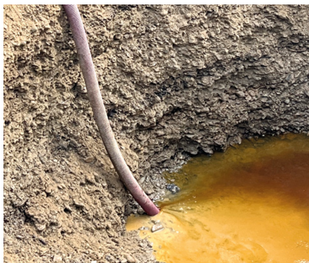
Odčerpávání benzenu z výkopu
