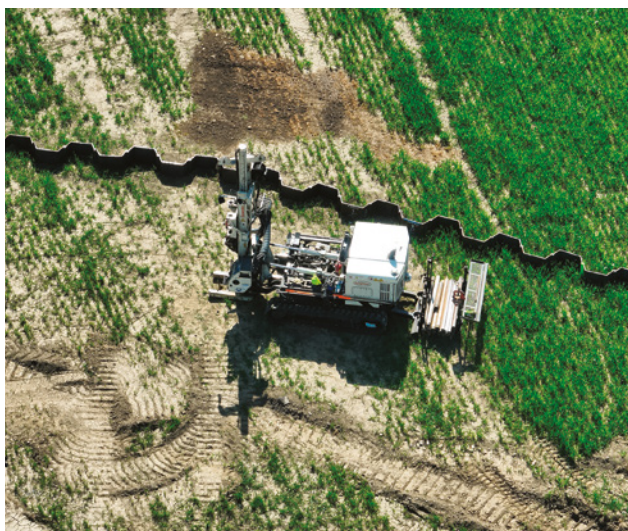
Průzkum technologií MIP kolem štetových stěn
