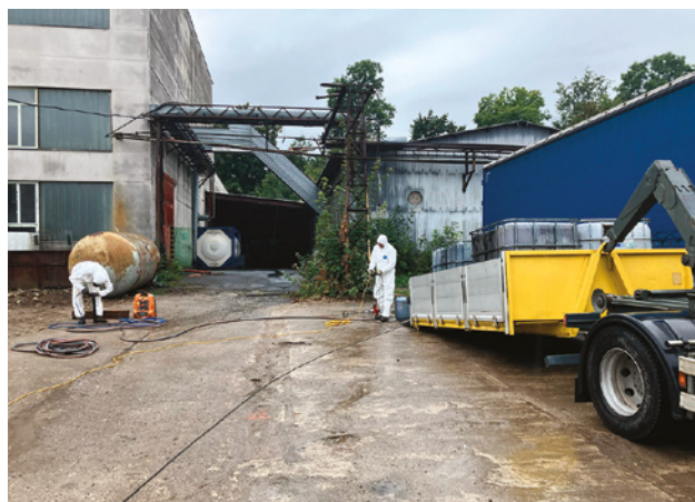
Injektáž kompozitu nZVI
