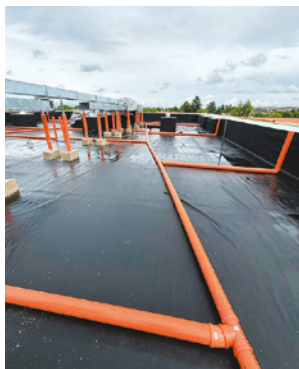
Sběrné potrubí PVC DN 110 před rozptřením souvrství filtru (vlevo) a rozvodné potrubí PP DN 110 a perforované potrubí PP d40 na povrchu filtru překryté půleným profilem PVC potrubí před překrytím zatěžovací vrstvou praného štěrku (vpravo).
