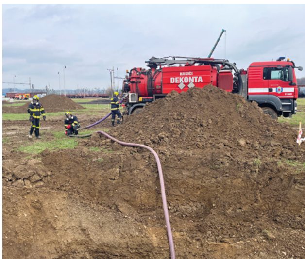
Odčerpávání benzenu specializovaným týmem Hasiči Dekonta
