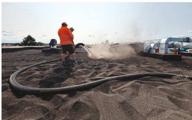
Doprava lehčeného i standardního kameniva do filtru na střeše.
