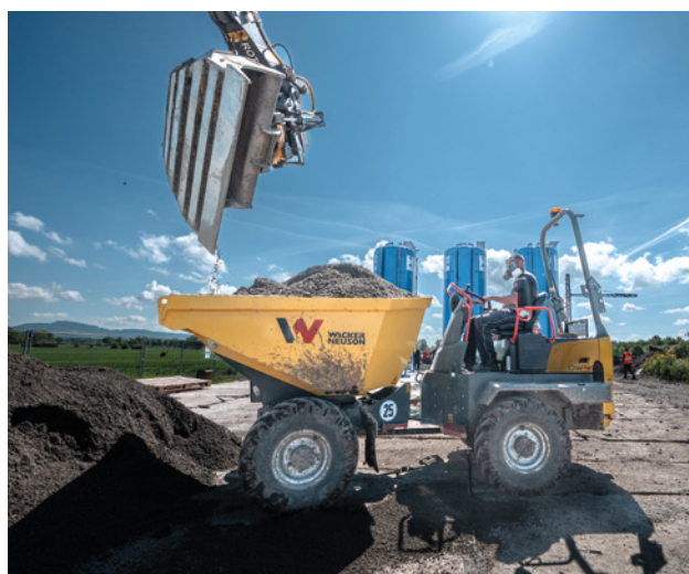
Úprava plochy pro sanační technologie za přítomnosti benzenu v ovzduší
