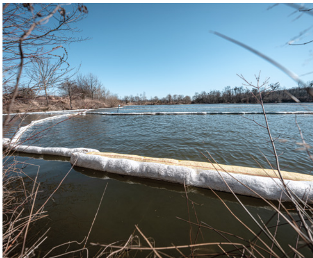
Zamezení šíření benzenu na hladině vody pomocí sorbčních hadů
