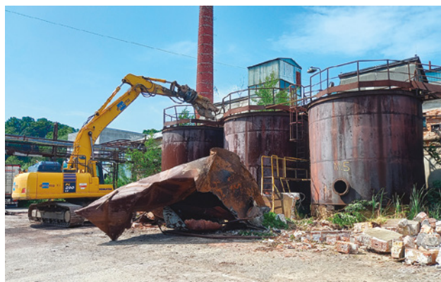
Demolice nádrží pomocí hydraulických nůžek
