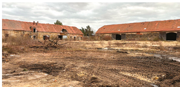
Pohled na stav areálu bývalého hospodářského dvora v centru obce Bašta před zahájením stavebních prací.
