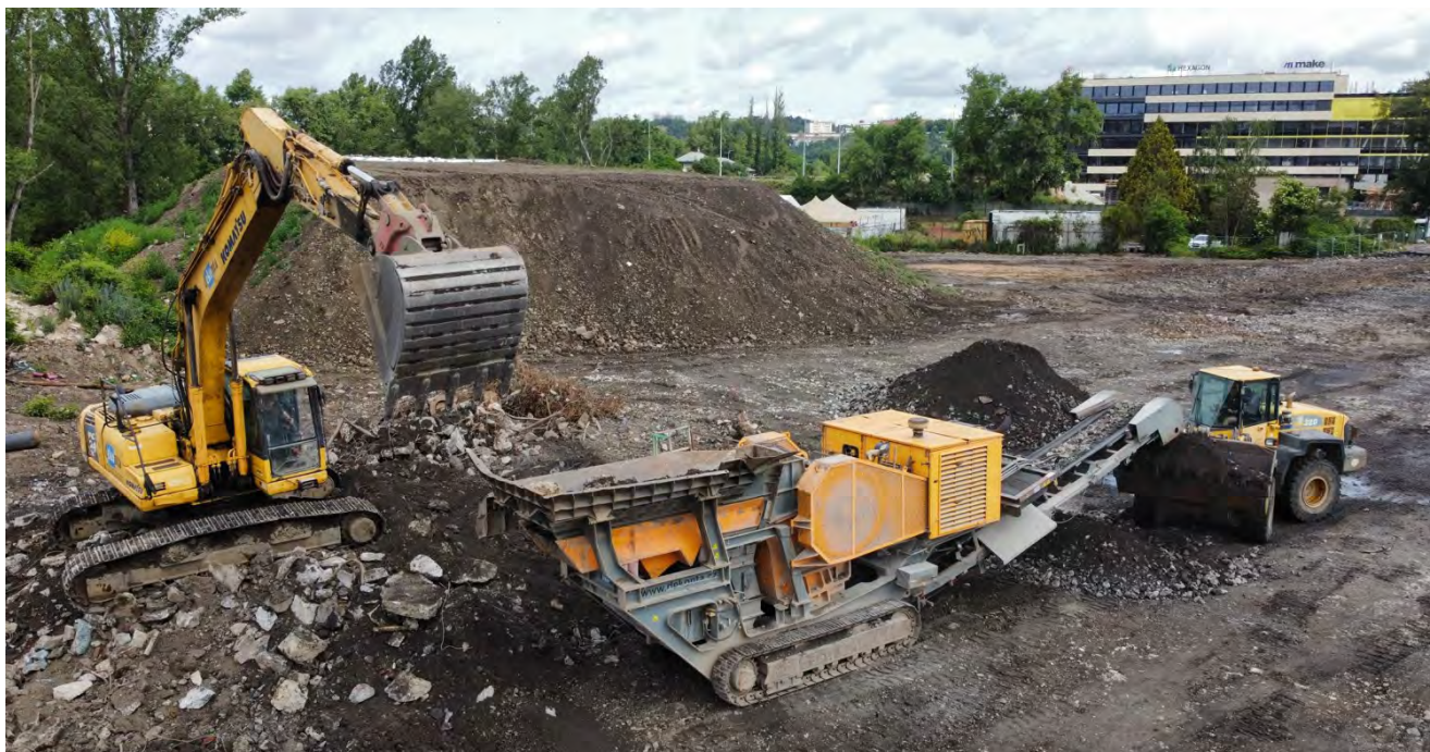
Zpracování stavebního odpadu na mobilní drtičce odpadů
