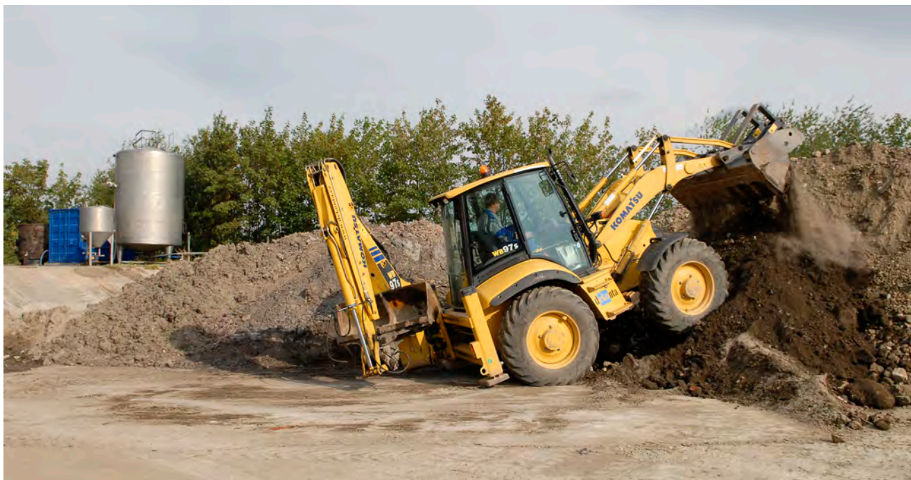
Provzdušňování zeminy na dekontaminační ploše
